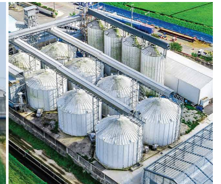
1공장 원료 저장시설
