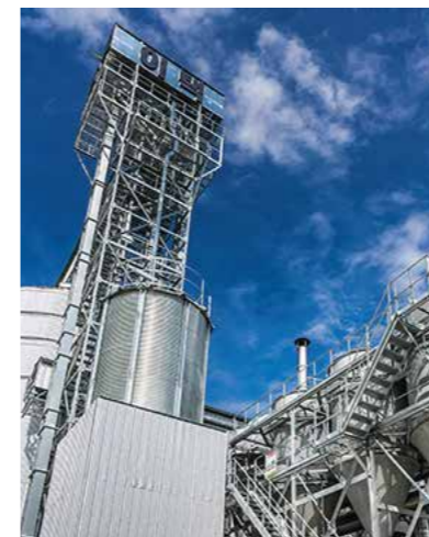
2공장 원료 저장시설
